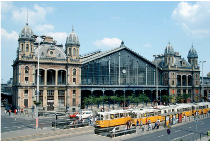
Estación ferroviaria Oeste de Pest, Budapest, Eiffel & Co
