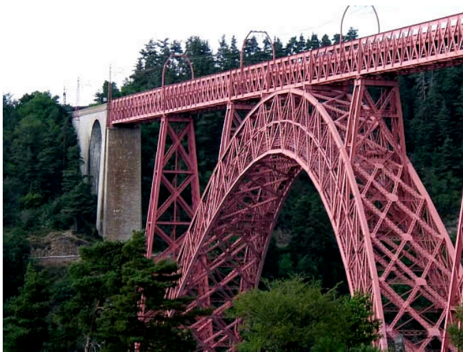
Viaducto de Garabit, Eiffel & Co
